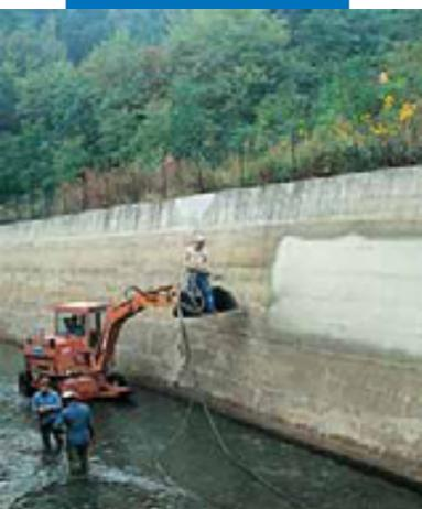
Нанесение Planiseal 88 напылением на подводный канал гидроэлектростанции
