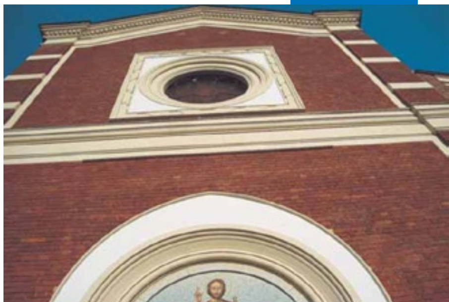
Кирпичная стена обработанная Antipluviol S
