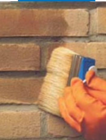
Нанесение Antipluviol S кистью
