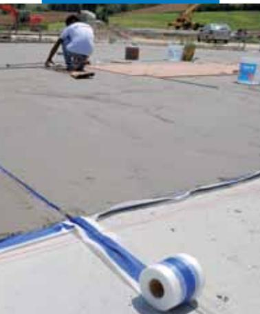
Гидроизоляция стяжки с применением Mapelastic и Mapeband
