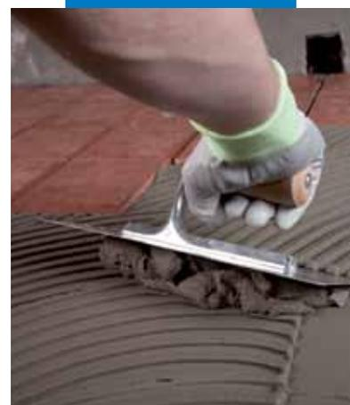
Нанесение Granirapid на гидроизоляцию Mapelastic на террасе
