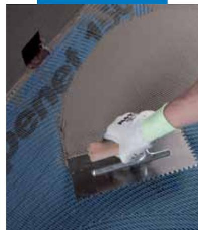
Нанесение Mapelastic на Mapenet 150
