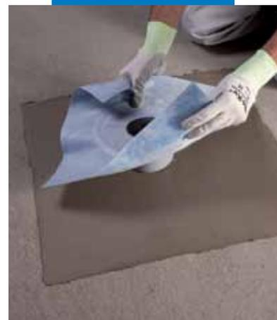
Установка Вертикального Дренажа на Mapelastic
