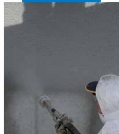
Нанесение **Mapelastic** на виадук путем распыления
